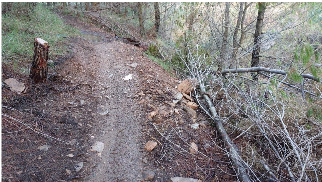
Κοκκιναράς - Κοπή δένδρων για διάνοιξη διαδρομής
