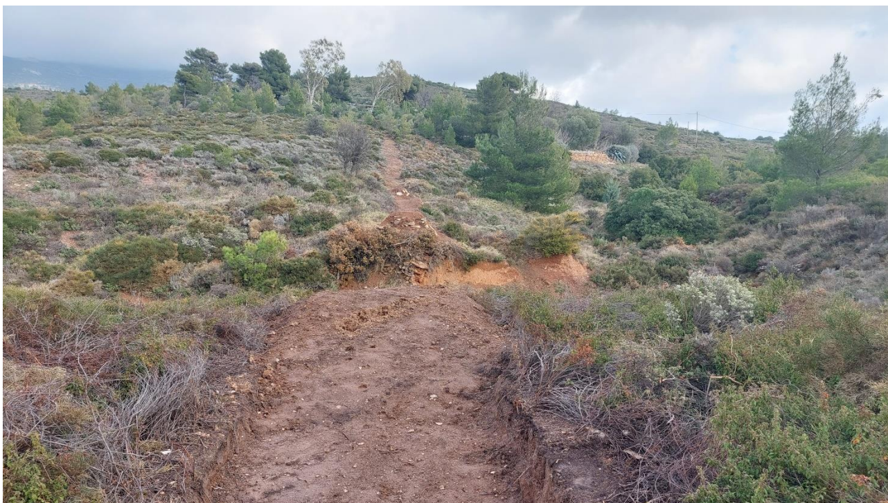
Κοκκινάρς -Κατασκευή Βατήρα πάνω από ρέμα
